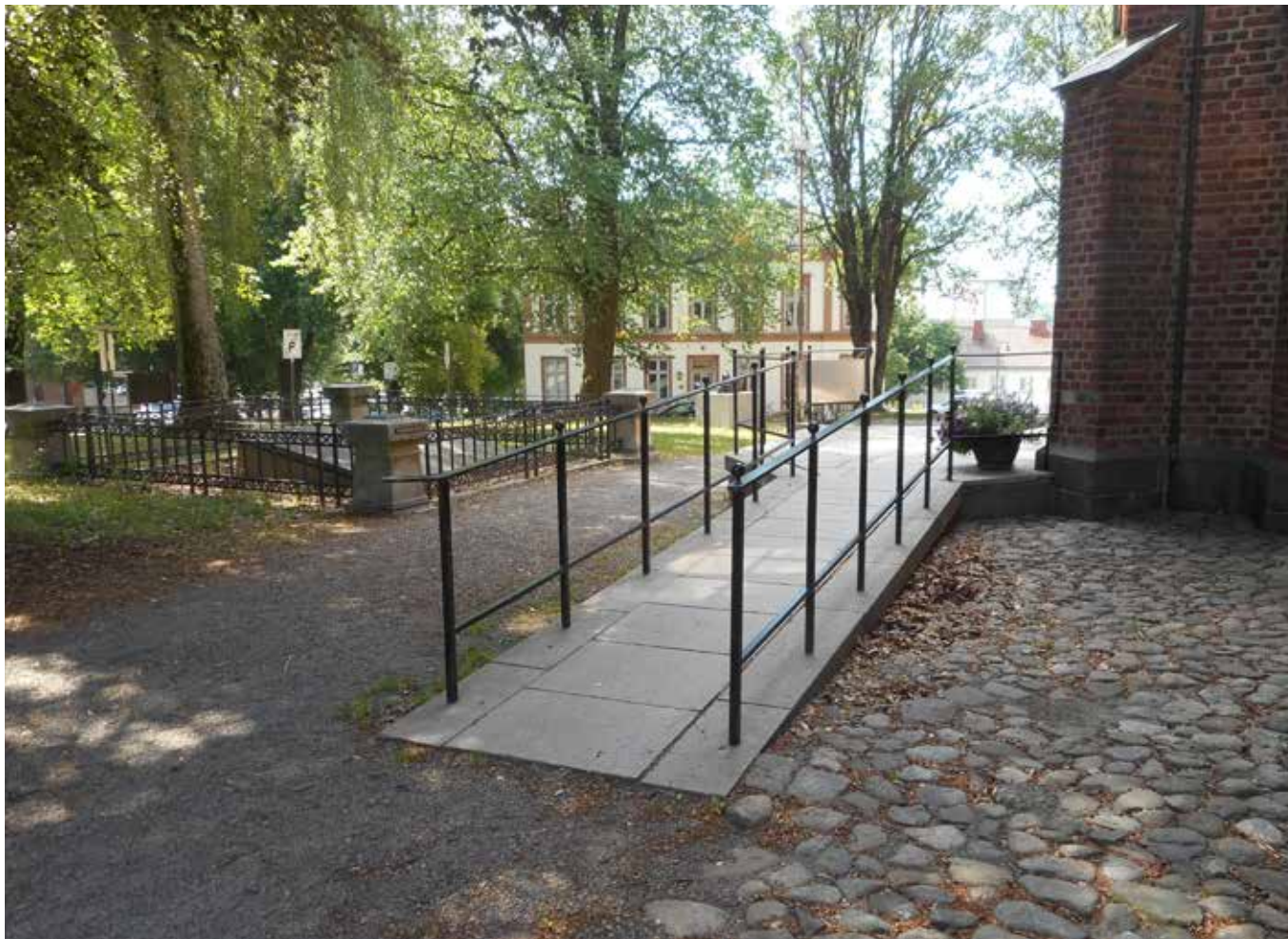
Granitrampe med smijnersrekkverk. Tidsriktig og tilpasset materialbruk.
