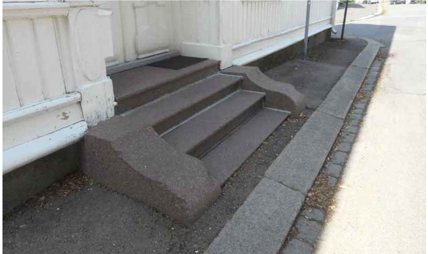
Utstikkende trapp til hinder i fortau. Ledelinje mangler. Fotgjenger tvinges ut i gaten.
