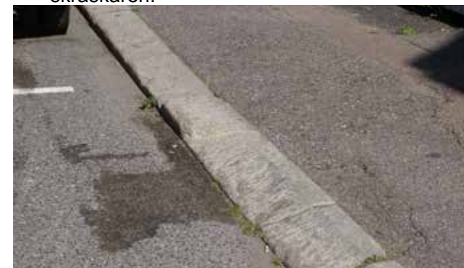
Senket kantstein mellom fortau og gatenivå.
