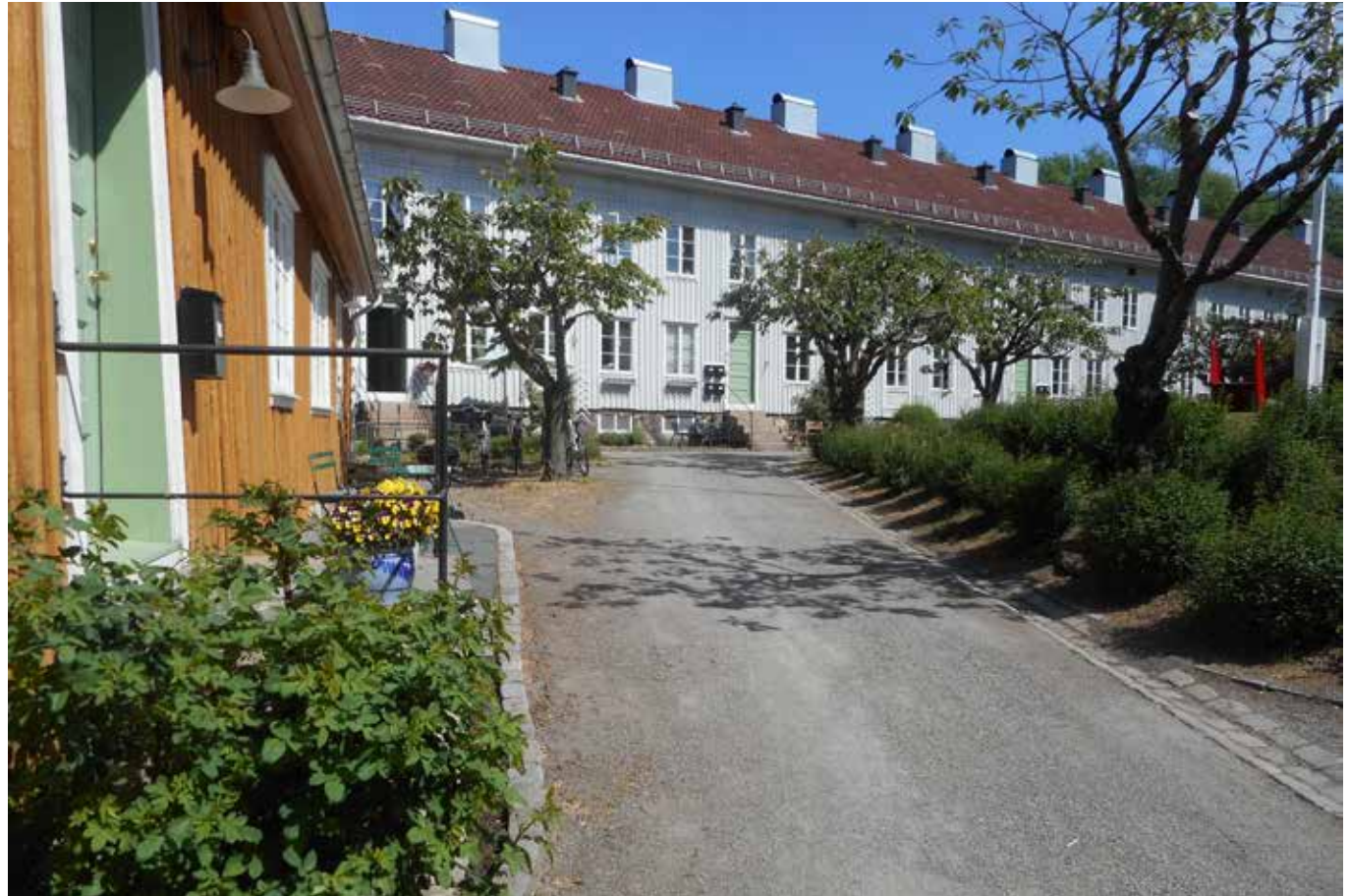
Gangvei i gårdsrom med naturlig ledelinje og renne for håndtering av overvann.
